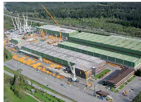
Firma Liebherr, Nenzing
