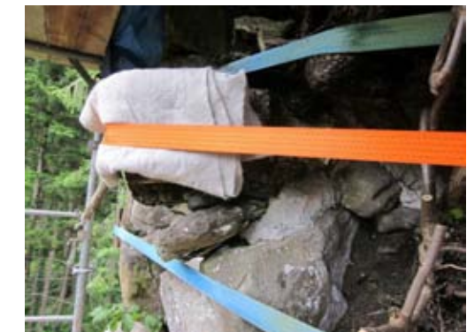
Restaurierungsarbeiten Ruine Schwarzenhorn
