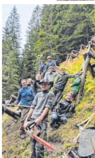
Feuerwehrgenossenschaft Schnifis errichtet Gleitschneeböcke. GÜNTER DÜNSER
